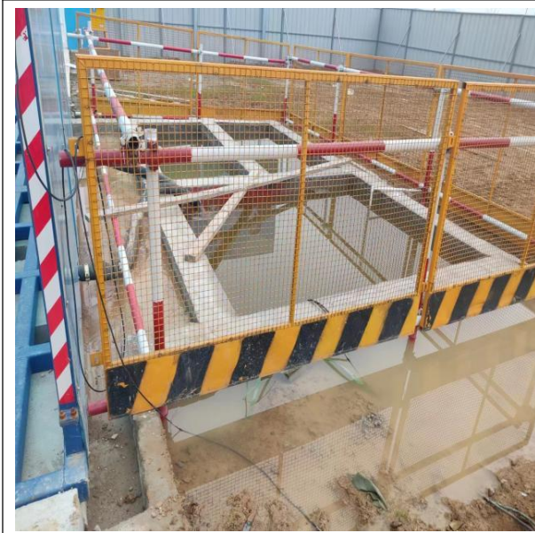
航站区待建航站楼临时沉沙池
