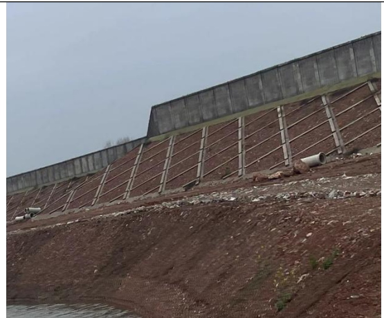
飞行区延长跑道西北侧边坡方格网骨架
