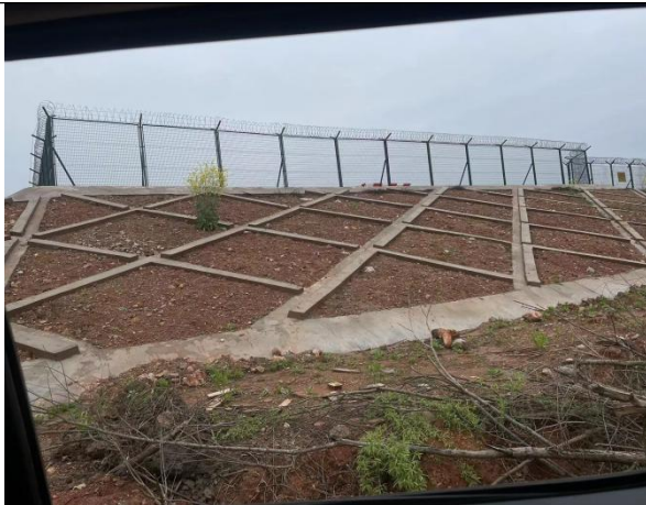
飞行区延长跑道西北侧边坡方格网骨架
