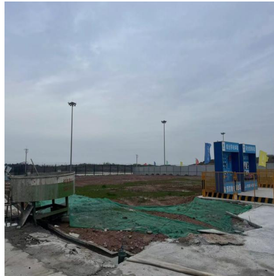
航站区草籽播撒区
