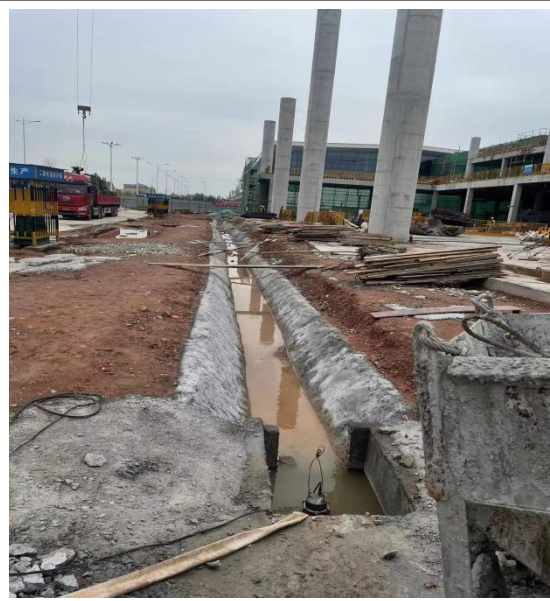
航站区航站楼临时混凝土排水沟及沉沙池
