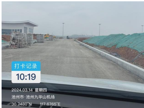
道路两侧临时堆土苫盖
