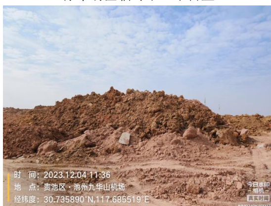
停车场区临时堆土未苫盖
