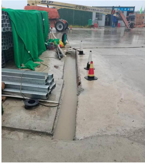
航站区临时排水沟
