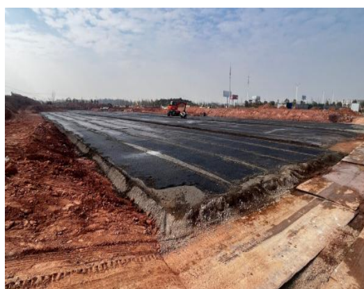
停车场施工现状
